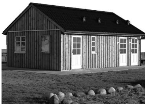
Den ny servicebygning. Foto: Læsø Museum
