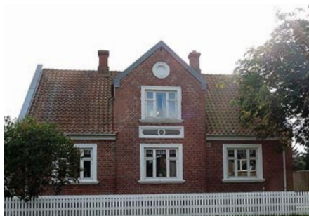
Huset bygget til Agnes og Asbjørn Thomsen. Nu Vesterø Havnegade 58 med front mod Havnegaden. 2016. Foto: privat eje
