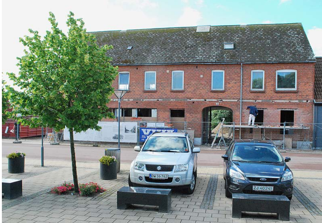
Facaden på det nye muse- umshus under ombygning i sommeren 2016. Foto: Læsø Museum
